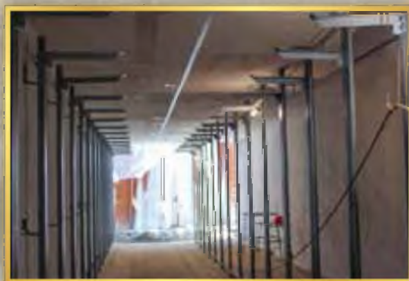
Строительство кабельного коллектора “Ваганьковский”
