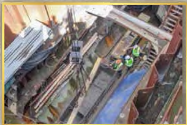
Строительство кабельного коллектора “Бескудниковский”
