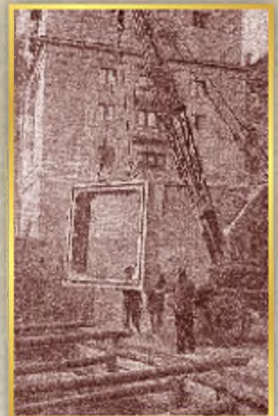
Строительство коммуникационного коллектора открытым способом. 50-е годы
