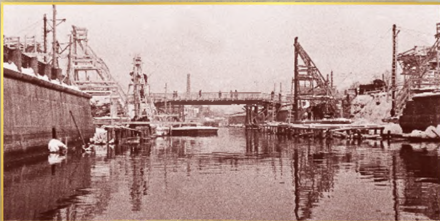
Строительство нового Астаховского моста, 1940 год
